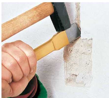
Пазовое зубило электрика Electrician's slotting chisels
